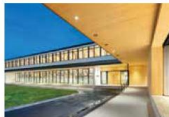
山形県 高畠町立図書館建設事業 (電気設備工事)
