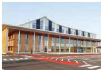
山形県川西町新庁舎 整備事業(電気設備)工事
