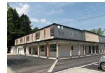
山形県米沢市 サービス付き高齢者向け住宅 奏で館(電気設備)工事
