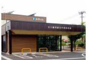
古川信用組合中新田支店様 移転新築(電気設備)工事
