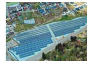
山形県 県営太陽光発電所(1000kw)
