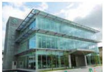
山形県 株式会社後藤組様 本社屋新築(電気設備)工事
