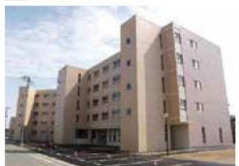
山形県米沢市 公営住宅塩井団地 建替等事業3号棟(電気設備)工事
