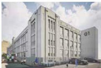
Q1やまがたクリエイティブシティセンター 改修電気設備工事
