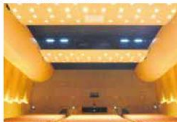
山形県南陽市 新文化会館 施設(電気設備)工事
