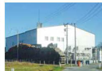
山形県 NKCながいグリーンパワー様 電気工事
