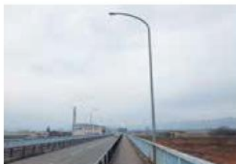
山形県 平成30年度(明許)道路保全事業 (交付金・道路照明対策国補正)一般国道287号 外道路照明灯更新工事(第2工区)
