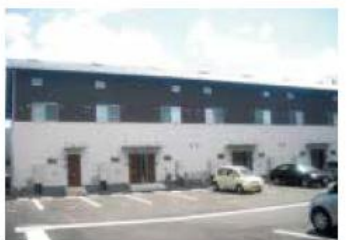
福島県福島市 CASA CIELO REAL 新築(電気設備)工事
