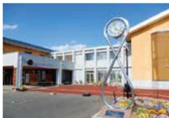
山形県 山形市立千歳小学校校舎改築 及び放課後児童クラブ新設電気設備工事
