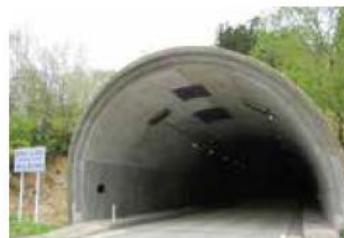
山形県 令和2年度(明許)道路施設長寿命化対策事業 (補助・トンネル・補正)主要地方道玉川沼沢線 叶水トンネル照明設備更新工事
